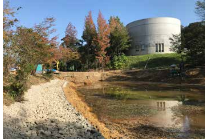
池の北面は金網の護岸に砂利敷を組み合わせた護岸を整備
