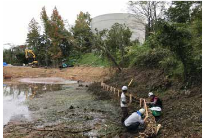
池の南面は枝を束ねたそだ垣による護岸を整備
