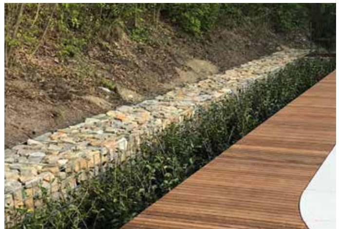
既存側溝上部に砂利が入った金属製のカゴを設置
