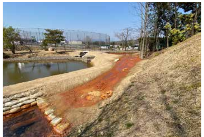
湧水地点から沈殿池をつなぐ池とは分離された水路
