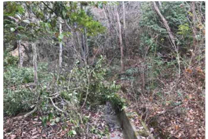
斜面からの土砂流入により詰まる側溝
