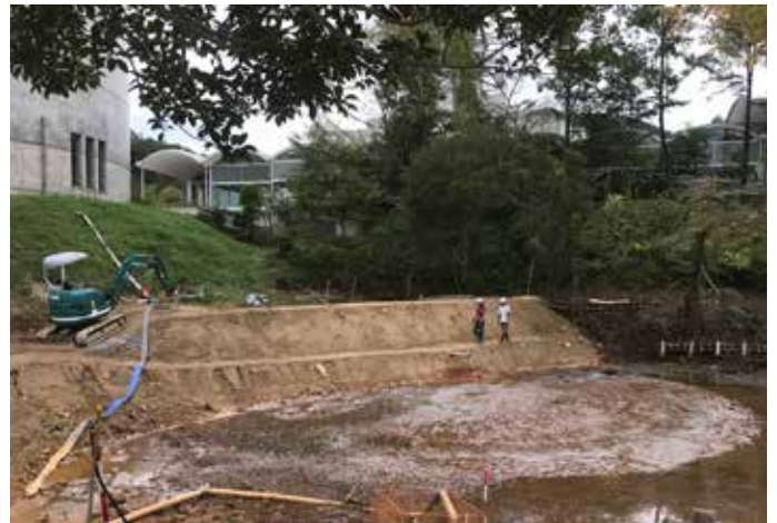
池と湧水を分けるための築堤
