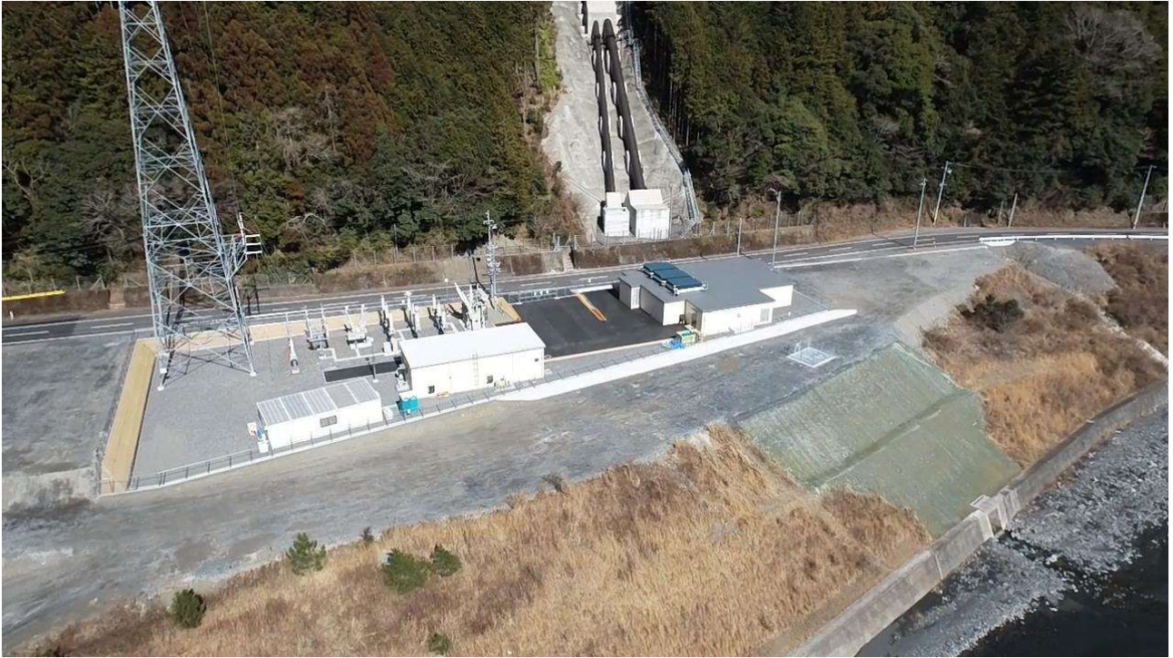
安倍川水力発電所（全景）
