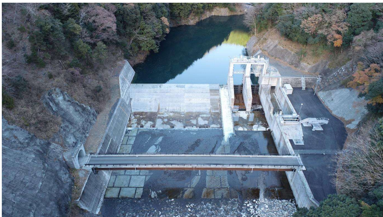
安倍川えん堤（下流から上流を望む）
